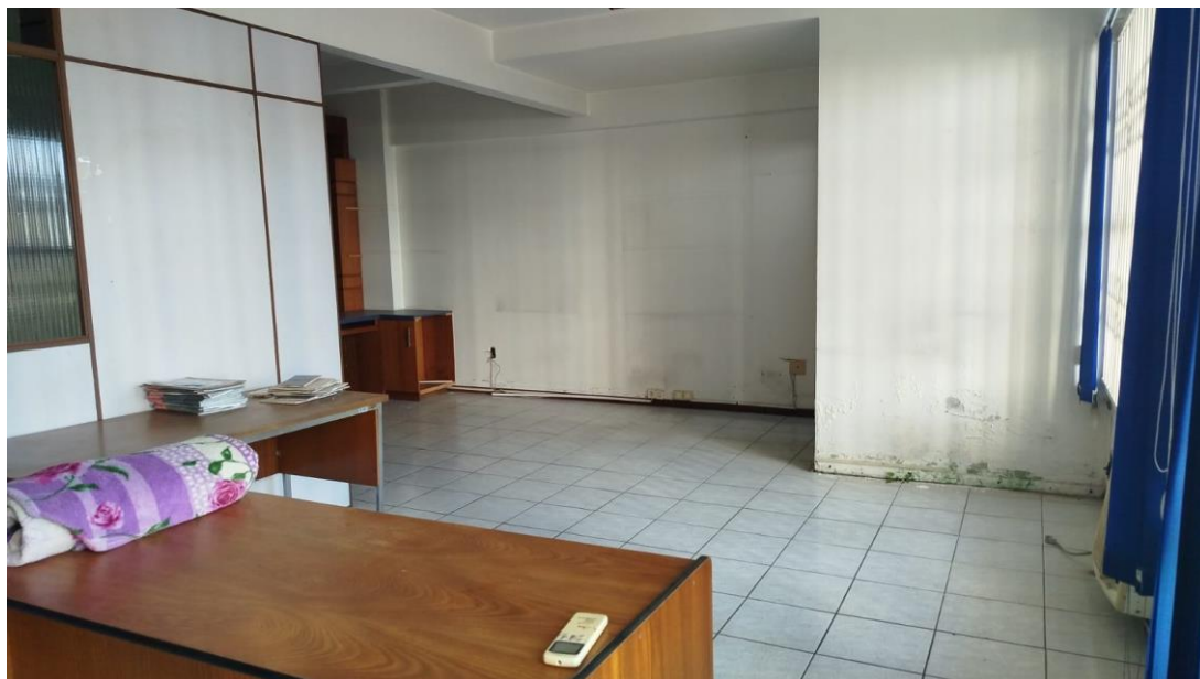
Foto 9: Sala interna Fonte: Carvalho Lira Engenharia, 2026
